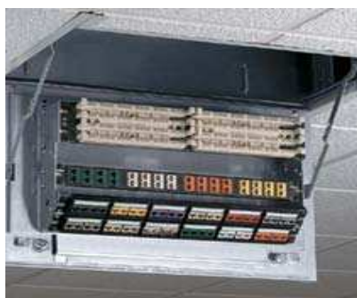
Příklad: rozvaděč CP pro montáž do sádkartonových podhledů
